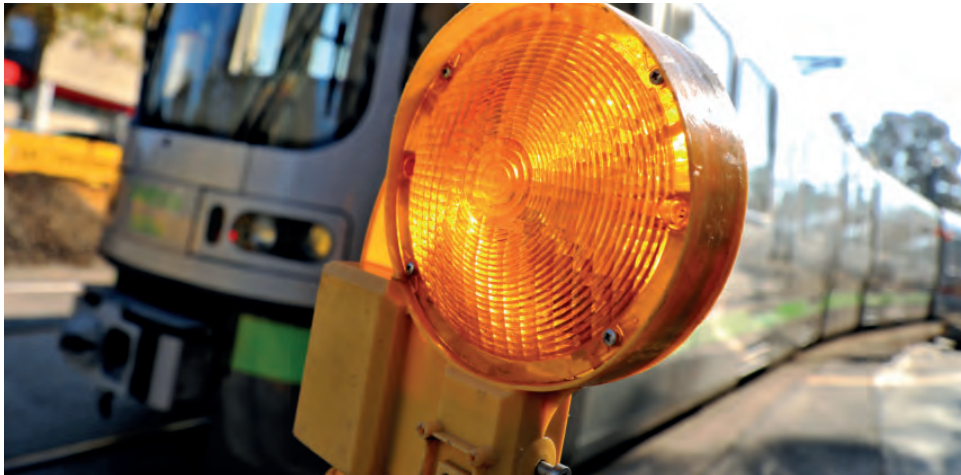
Die Pflege von Gleisen und Anlagen ist notwendig – auch in 2019.
