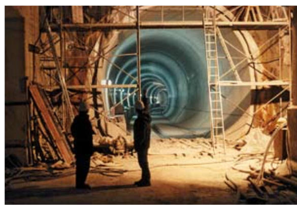
Der Bau einer Tunnelröhre
