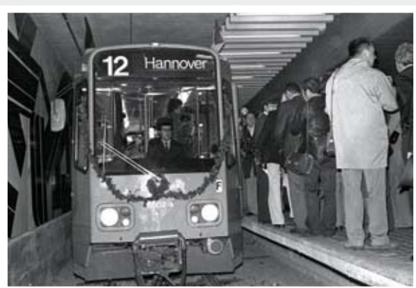
Eröffnung des ersten Tunnelabschnitts
