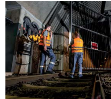
Während der Betriebspause werden die Rampentore überprüft.
