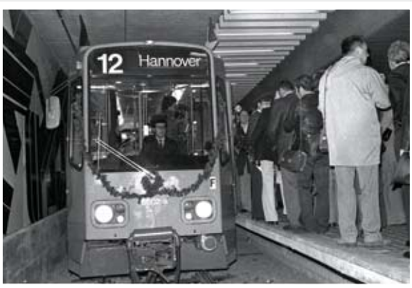
Eröffnung des ersten Tunnelabschnitts
