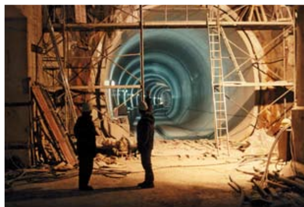
Der Bau einer Tunnelröhre
