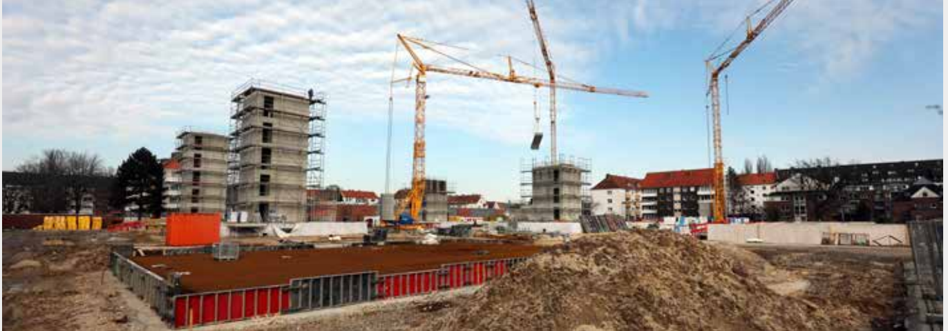
Neben dem Busbetriebshof in Vahrenwald entstehen die neuen Werkwohnungen.
